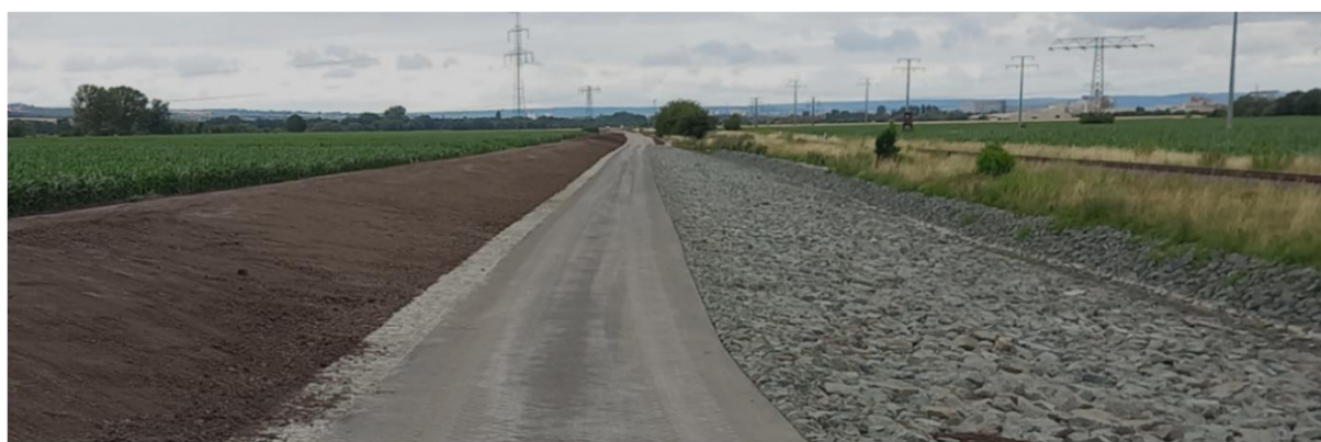
Abbildung 2 Bereits umgesetzter Bauabschnitt 1.1 mit Überströmstrecke (Quelle: ThLG)
